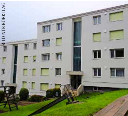
Sanierte Fassade mit Lüfterauslässen.
